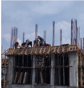
Gambar 8. Pemasangan bekisting
