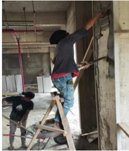
Gambar 11. Memplester dinding
