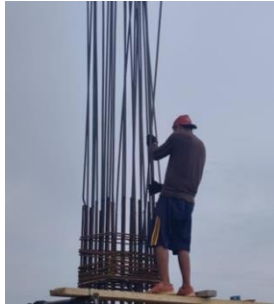
Gambar 7. Pemasangan besi tulangan
