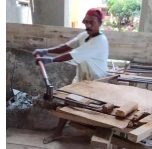
Gambar 5. Pembuatan besi begel
